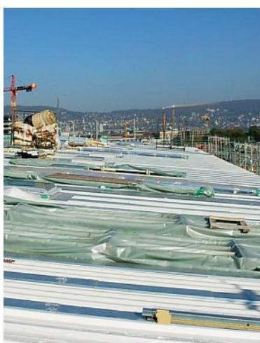
**Zweite Haut:** die Profilbleche bilden die zweite Haut und dichten den Baukörper vollständig ab. Sorgfältig sind Dachfenster und Abluftkamine eingefasst. Anschliessend werden die Solarpaneele der Photovoltaikanlage montiert und die Sinusbleche aufgeschraubt.
