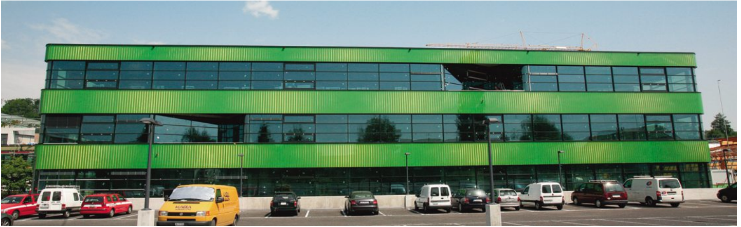
Der Pfosten-Riegel läuft über die ganze Fassadenhöhe. Gut zu erkennen, die Balkonnischen mit ihren gerundeten Glaszargen.
