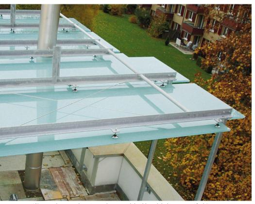
Die Gläser sind an einzelnen Tragjochen mit Edelstahl-Punkthalterungen aufgehängt. Les vitrages sont suspendus à différentes palées porteuses au moyen de fixations par points en acier inoxydable.
