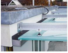
Gebäudeanschluss mit Wasserrinne. Raccordement côté bâtiment avec chéneau.
