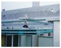
Detailansicht kurz nach der Glasmontage. Die Verbindungsrohre sind noch nicht befestigt.
