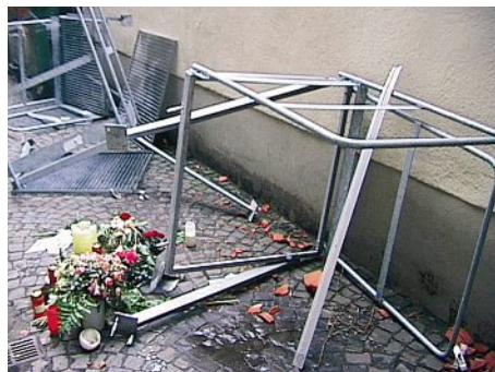
Das sind die folgenschweren Auswirkungen einer falschen Notpodestbefestigung in Köln.
