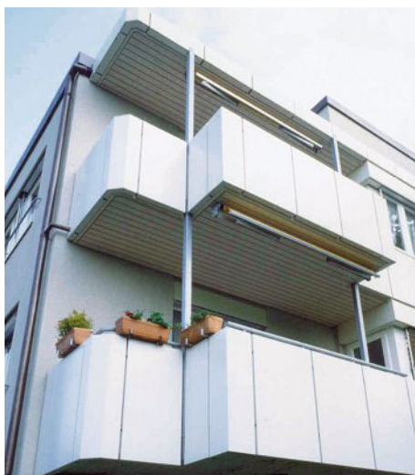
Typisches Anwendungsbeispiel von geformten Verbundplatten
