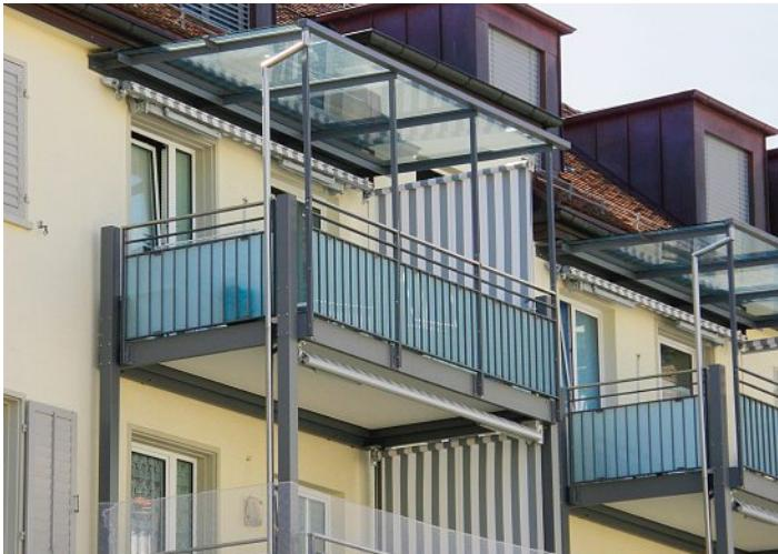
Die Bodenplatten sind über die rechteckigen Aluminiumstützen gesteckt gestapelt. Leicht wirkt auch die gläserne Überdachung.
