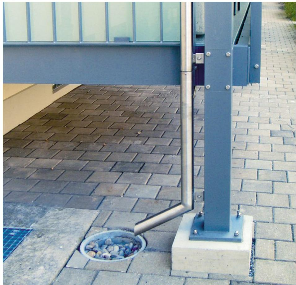
Detailansicht von aussen. Das Balkonsystem besteht komplett aus Aluminium: Stütze, Balkonrahmen, Fussplatte und Geländer.
