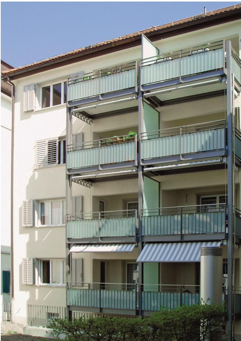
Eine ruhige und harmonische Wirkung auch von unten. Die verwendeten Balkonplatten fordern keine zusätzlichen - von unten sichtbaren - Sprossenprofile.
