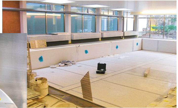
Legierungsanalyse der Schweissnähte eines Schwimmbeckens aus nicht rostendem Stahl.
