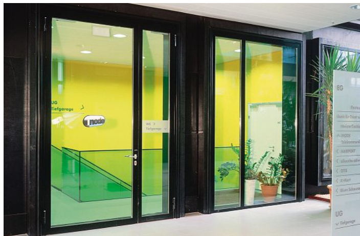
Feuerschutzabschluss als Fluchtweg.
