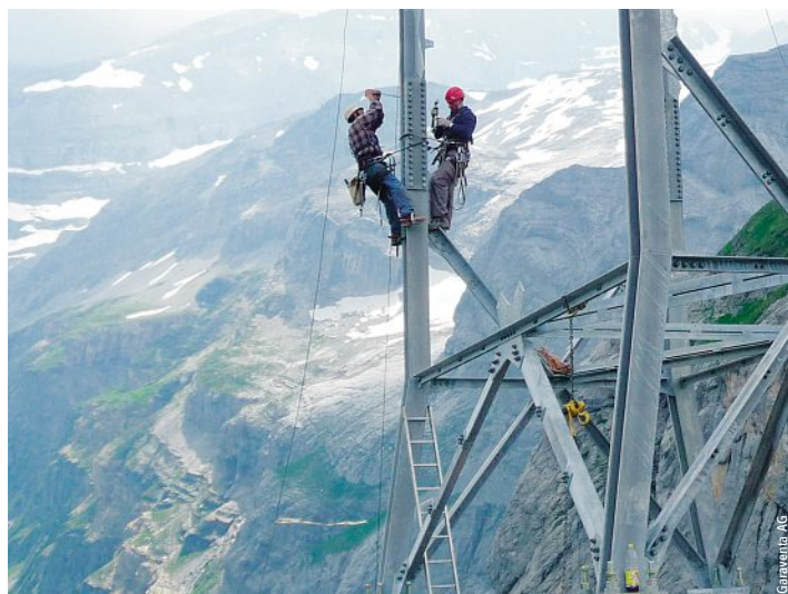
Bau einer Fachwerkstütze in Linth-Limmern.
