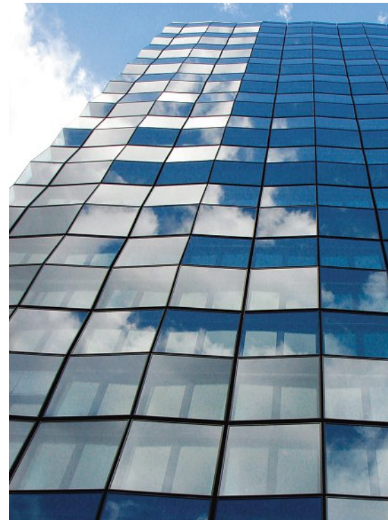
Nicht nur architektonisch ein Highlight: Der fast 100 m hohe Büroturm.
