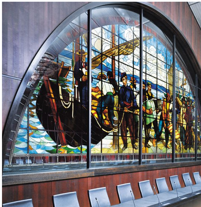
Ein einzelnes Bogenfenster fasst rund 50 m 2 Brandschutzglas EI30. Un seul vitrail plein-cintre nécessite près de 50 m 2 de vitres antifeu EI30.
