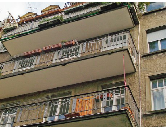
Die alte, verkommene Fassade vor der Sanierung.
