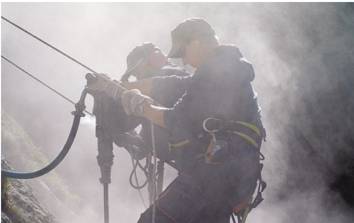
Glashartes Gestein und steiles Gelände erschwerten die Bohrungen für die Verbundanker.
