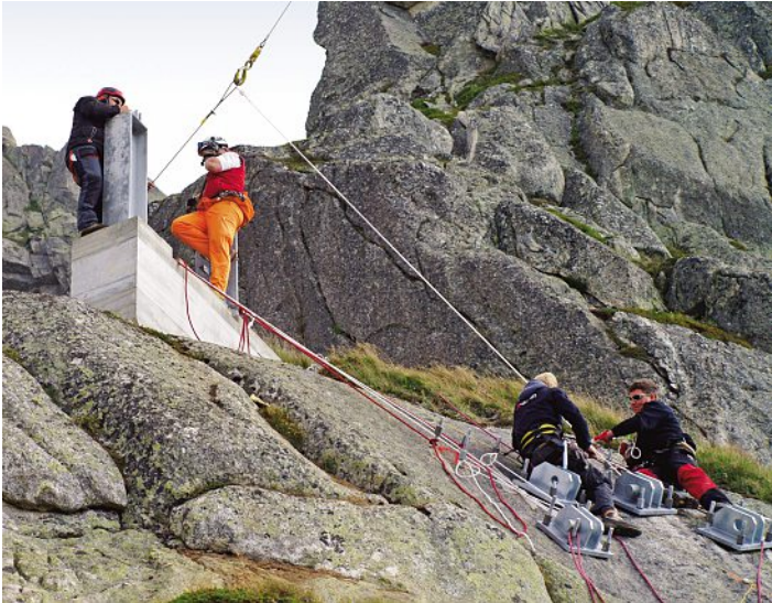
Die Stahlpylone sind in den Betonfundamenten eingegossen. Les pylônes d'acier sont coulés dans les fondations en béton.
