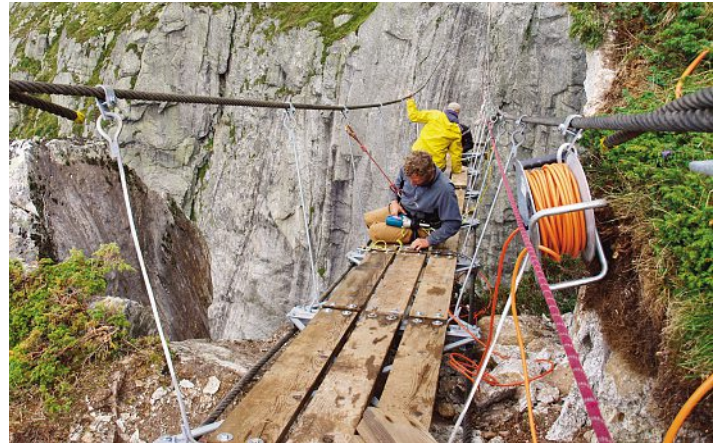
Die Befestigung der Hängerkonstruktionen und das Auflegen der Laufstegbretter erfolgte Hand in Hand.
