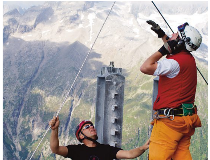
Die Tragseile werden mit dem Helikopter über die Schlucht gelegt. Hinten zu erkennen, der Pylonkopf mit der Führung für die Tragseile. Les câbles porteurs ont été dévidés au-dessus de la gorge par hélicoptère. On remarque la tête de pylône avec le dispositif de guidage des câbles porteurs.
