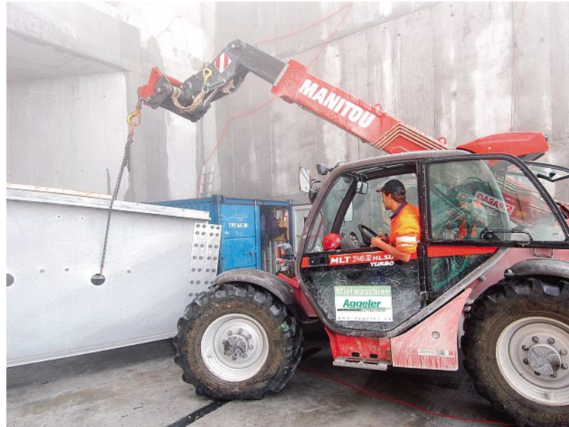
Der Manitou-Teleskoplader MLT 742 platziert diesen schwergewichtigen Eisenträger für die Bergstation am richtigen Ort.
