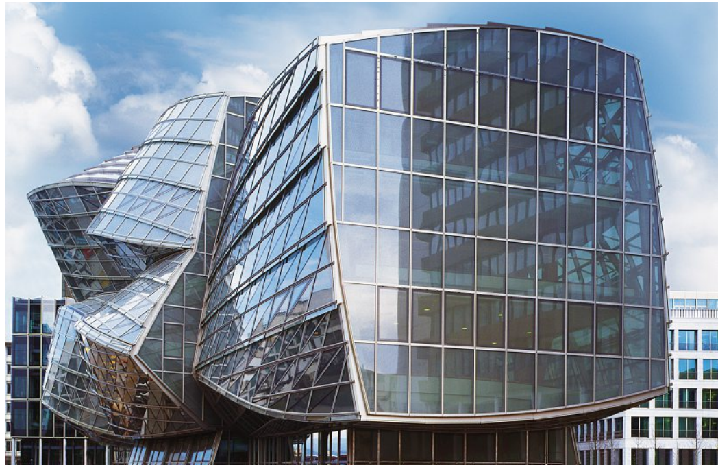
In der Dachfassade sind Fotovoltaik-Elemente integriert. Des éléments photovoltaïques sont intégrés dans la façade de toit.
