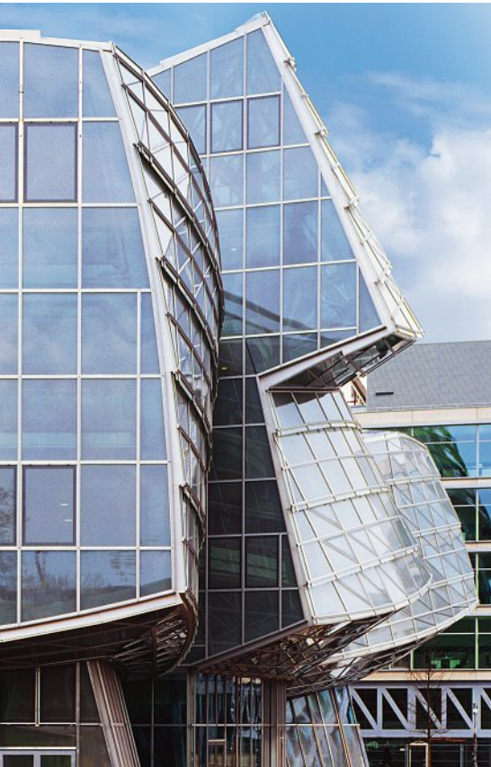
In der Dachfassade sind Fotovoltaik-Elemente integriert. Des éléments photovoltaïques sont intégrés dans la façade de toit.
