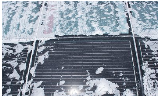
Temperaturen von +30°C bis -40°C sind berücksichtigt. Prise en considération de températures variant de + 30°C à -40°C.
