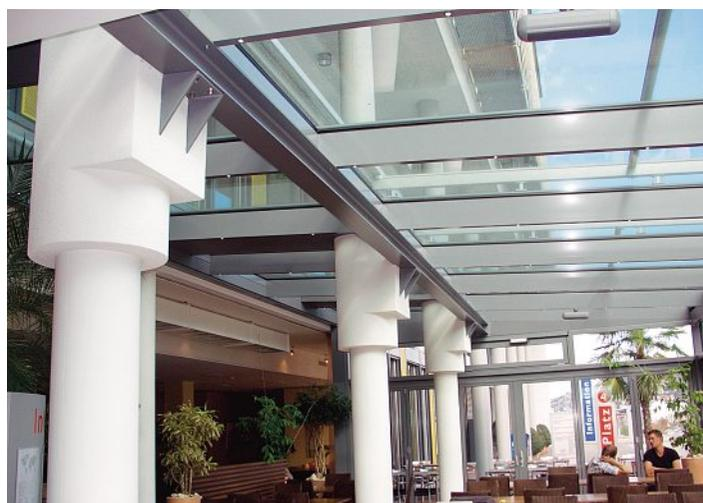
Ein durchlaufender HEA-Träger nimmt einen grossen Teil der Dachlasten auf und trägt diese auf die Betonsäulen ab.
