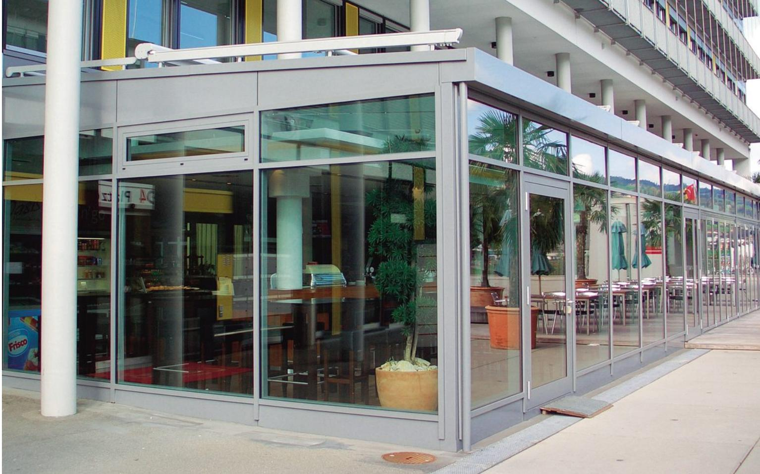
Die Vertikalfronten sind als tragende Elemente in Stahl ausgeführt.
