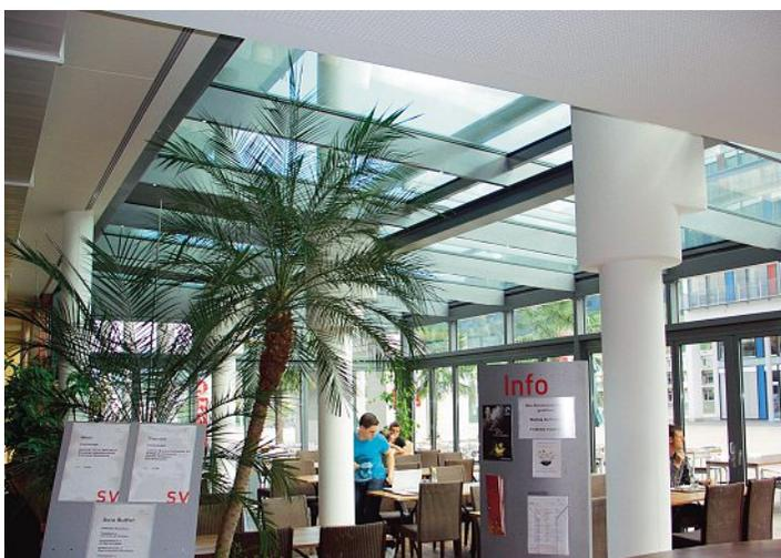
Das Aluminium-Dachgerippe ist in mehrere Elemente geteilt, fertig bestückt, angeliefert worden.
