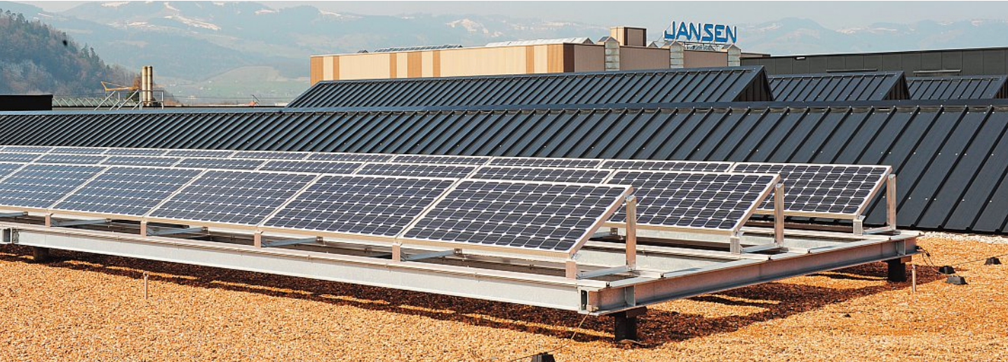
Polykristallin-Module, Typ Schüco SPV 180-SMY-2, erzeugen pro Jahr rund 8400 kWh Energie. Les modules polycristallins de type Schüco SPV 180-SMY-2 génèrent env. 8'400 kWh/an.
