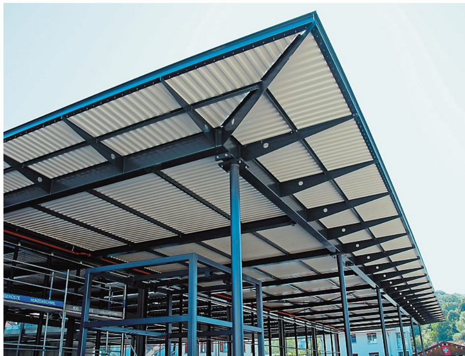
Aussenüberdachung mit auskragendem Vordach vor der Verkleidung. Toiture extérieure avec avant-toit en saillie avant le revêtement.
