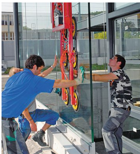
Mit der Saugvorrichtung lassen sich auch grossformatige Gläser problemlos einsetzen. Le système d'aspiration permet d'utiliser aisément des vitrages grand format.
