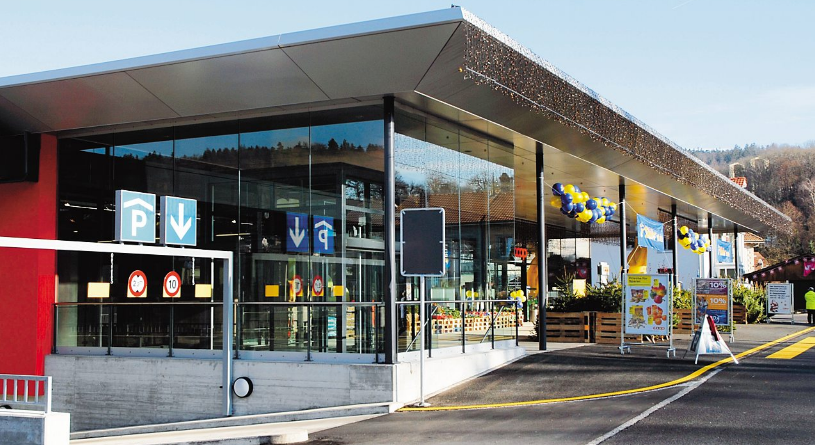
Coop setzte neue Massstäbe in Schönenwerd. Hohe Lebensqualität, tiefe Energiekosten. Coop établit de nouvelles normes à Schönenwerd. Qualité de vie élevée, dépenses d'énergie minimales.
