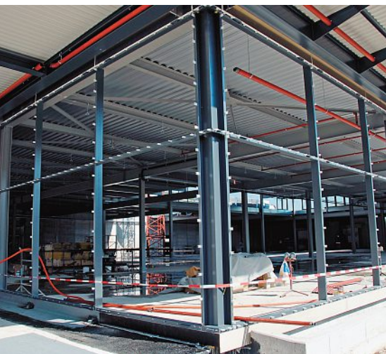
Das Gerippe der Pfosten-Riegel-Konstruktion im System SPR50. L'ossature avec montants et traverses System SPR50.
