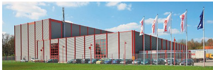
Die Hydro Building Systems hat in ihren Lager- und Logistik-Standort in Gerstungen fast 2 Millionen Euro investiert.
