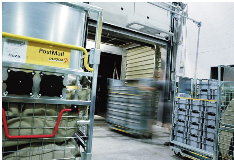
In Zürich-Mülligen hat TS Tor & Service AG, 68 Brandschutztüren eingebaut.
