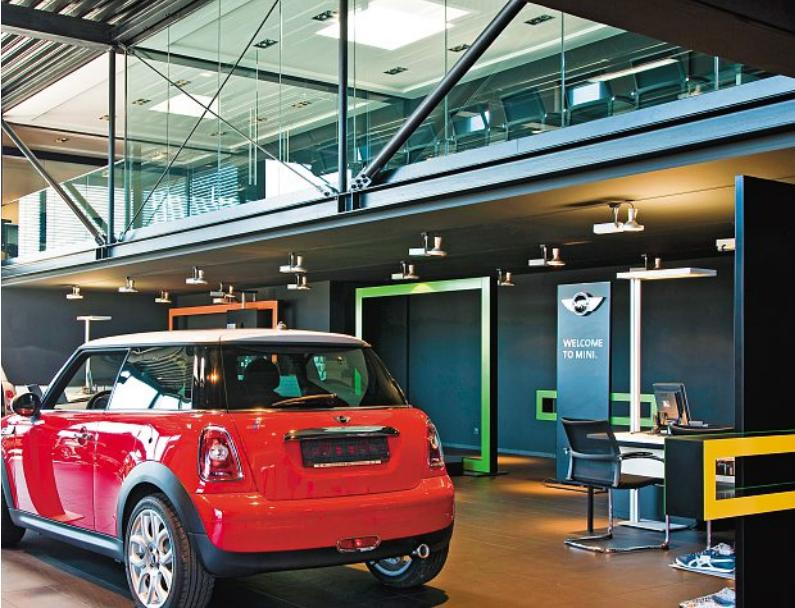
Im Obergeschoss ist ein Besprechungsraum als Stahlkonstruktion «eingehängt». Die sichtbaren Auskreuzungen verdeutlichen die Kräfte des Tragwerks. Die Verglasung besteht aus 8 mm starkem VSG.
