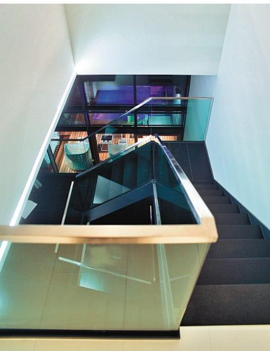
**Tolle Wirkung: Filigrane Flachstahlwange direkt an die Wand geführt.**
