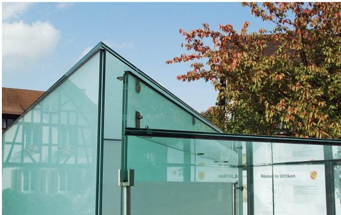
Im Zentrum das vertikale, tragende Glasschwert. Oben geklebt, unten mit Punkthalterungen befestigt. Die Kraftabtragung erfolgt über Edelstahlkonsolen. Au centre, l'entretoise porteuse verticale en verre, collée en haut et maintenue en bas au moyen de fixations par points. Les charges sont réparties par des consoles en acier inoxydable.
