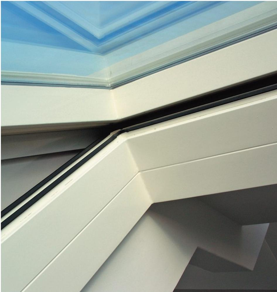
**Der optimale Anpressdruck auf die Gummidichtungen wird mechanisch reguliert.**
