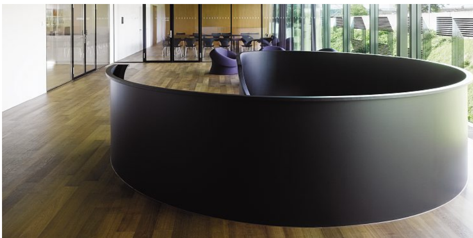
Gewundener Ausstieg – auch als Horizontalgeländer wirkend. Sortie sinieuse servant également de balustrade horizontale.
