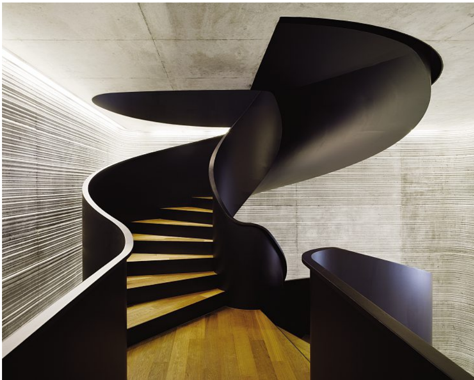
Komplett aus Stahlblech verschweisst: die Wangen aus 10-mm-, die Stufen aus 8-mm-Blech. Élégance et légèreté optimales malgré un matériau lourd.
