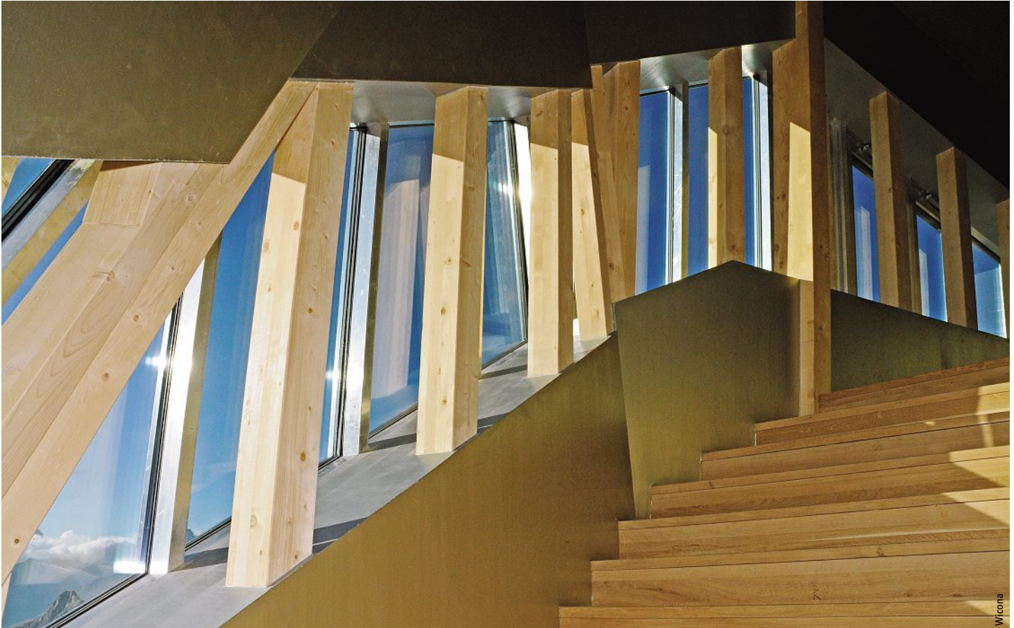
Innenansicht: Das Tragwerk ist aus Holz geschaffen. Die Fensterbänder aus einem Pfosten-Riegel-System von WICONA. Vue intérieure : ossature en bois. Rangée de fenêtres selon le système poteaux/traverses de WICONA.
