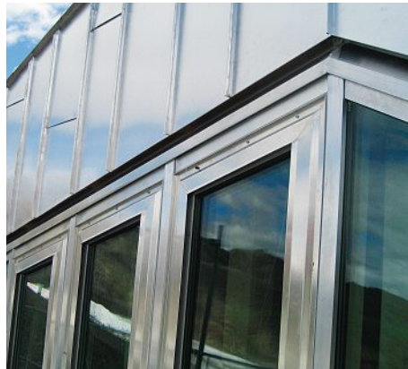
Der Fensterzarge ist vor Ort verschweisst worden. Le châssis de la fenêtre a été soudé sur place.
