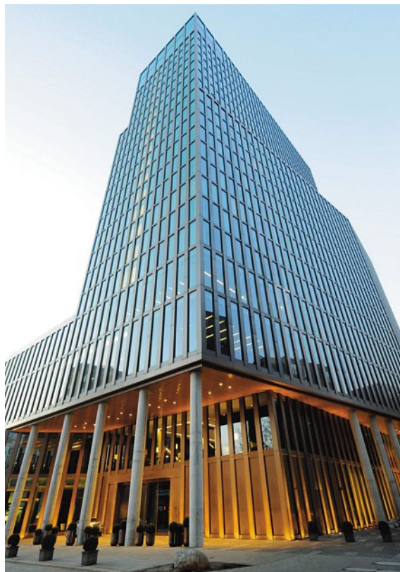
Am Empire Riverside Hotel in Hamburg sind 6300 m 2 Sicherheitsglas und 42 km WICONA-Profilen verbaut worden.
