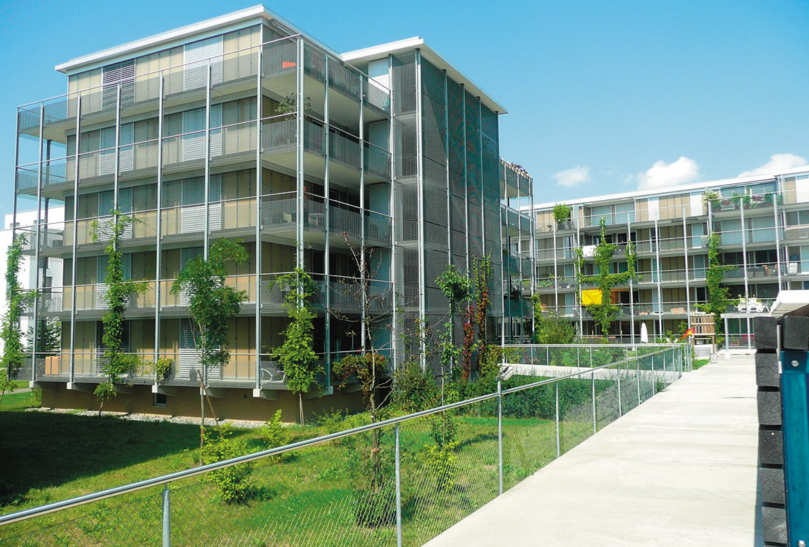
Die Überbauung besteht aus drei Einzel- und drei Doppelhäusern, welche allseitig mit Gitterrosten ummantelt sind. Le complexe comprend trois bâtiments individuels et trois bâtiments jumeaux, entourés de caillebotis.
