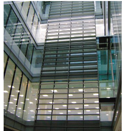
Blick von unten: Die stirnseitig angebrachten Aluminiumlamellen verhindern die Blendwirkung. Vue de dessous : les lamelles en aluminium à l'avant empêchent tout éblouissement.
