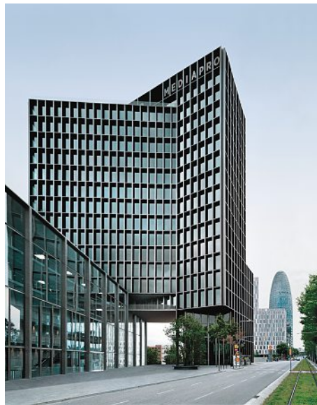
Die beiden Fassaden scheinen ineinander zu greifen. Das rasterartige Gerippe besteht aus aneinander gereihten Vierendelträgern.
