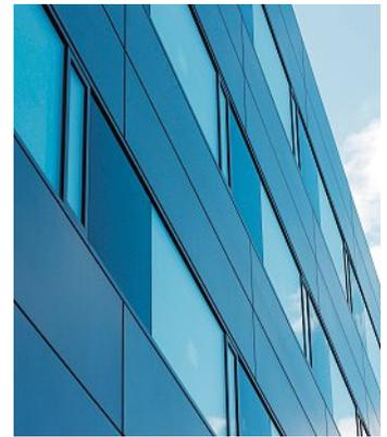
Neben der Fensterserie WICLINE 77 kam eine Pfosten-Riegel-Konstruktion auf Basis von WICTEC 50 zum Einsatz.
