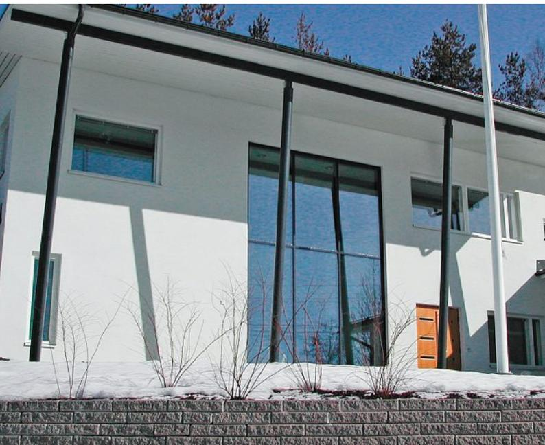
Pilkington Optitherm™ GS ist speziell für Dreifachisoliertgläser entwickelt worden und kombiniert hervorragende Wärmedämmwerte von bis zu 0,5 W/m<sup>2</sup>K mit einer hohen Energiedurchlässigkeit von bis zu 57 Prozent.
