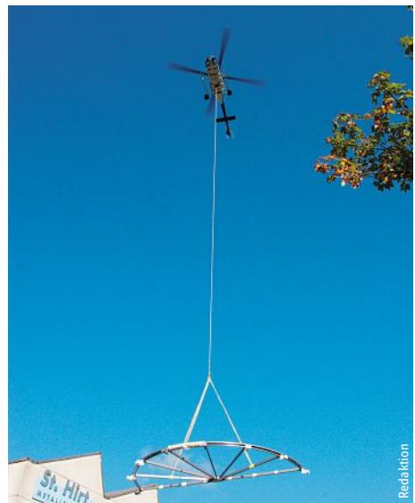
Der Transport des Vordachs erfolgte durch die Luft, direkt vom Werk Rümlang an den Zielort. Die heikle Mission ist von der Central Helikopter Services AG in Meggen durchgeführt worden. Le transport de la toiture de l'avancée ronde a eu lieu par la voie des airs, de l'usine de Rümlang jusqu'au chantier. Cette délicate mission a été assurée par Central Helikopter Services AG de Meggen.
