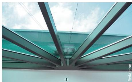
Für das strahlenförmige Dach mit seiner SSG-Verglasung musste technisch eine absolute Sonderlösung erarbeitet werden.
