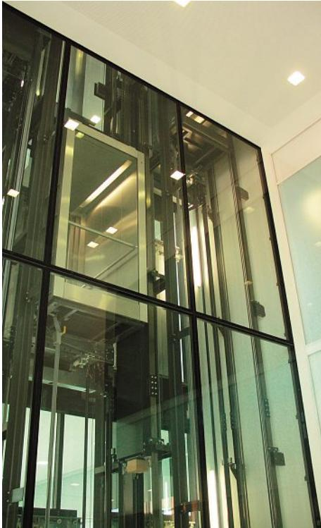
Die Rückfronten der Liftanlage. Die Gläser sind schrittweise durch die offene Halle zum Zielort gehievt worden.
