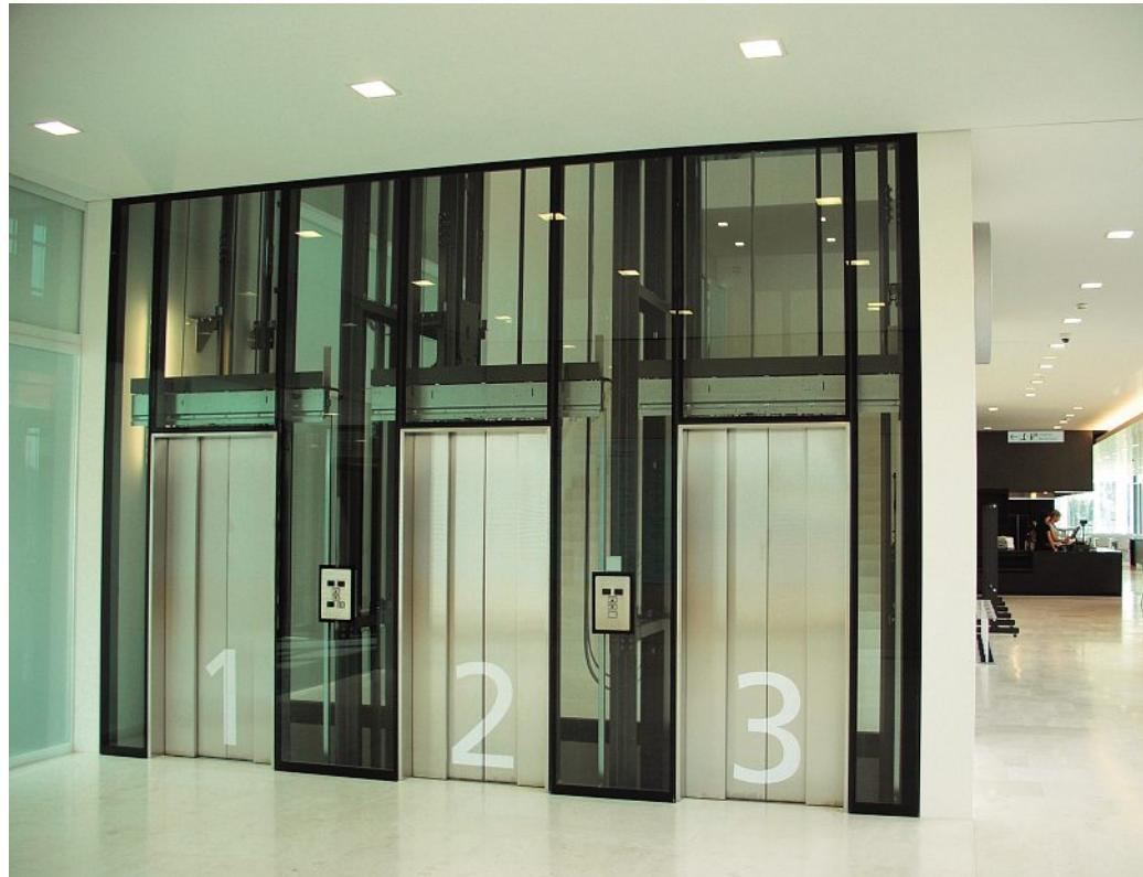
Elegant und transparent: Die Eingangsfronten der Dreiergruppe im Erdgeschoss. Die Drucktasten-Armaturen sind flächenbündig im Glas eingelassen.
