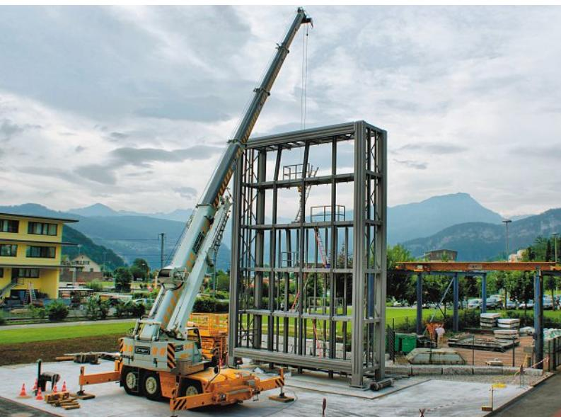
Alleine die Tragkonstruktion wiegt rund 35 Tonnen.
