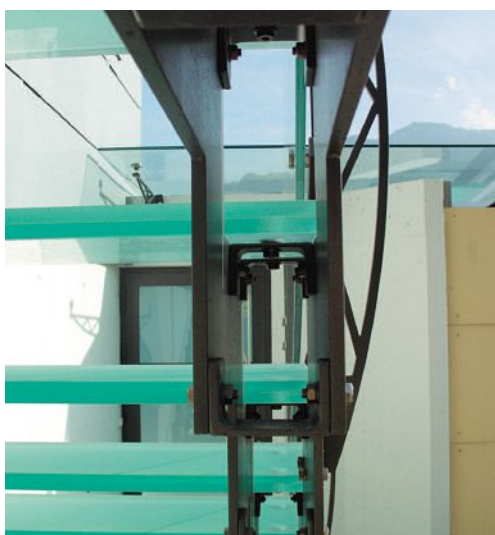
Detailansicht der doppelt geführten Treppenwangen. Détail des limons doublés.
