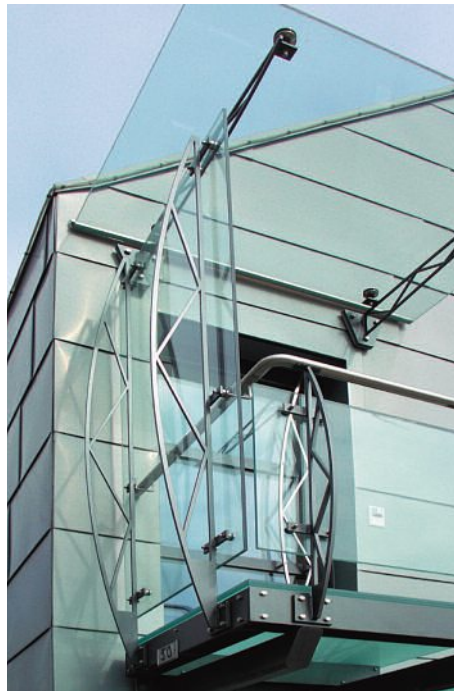
Ausstentreppe, Geländer, Schutzwand und Vordach – alles im einheitlichen Stil.
