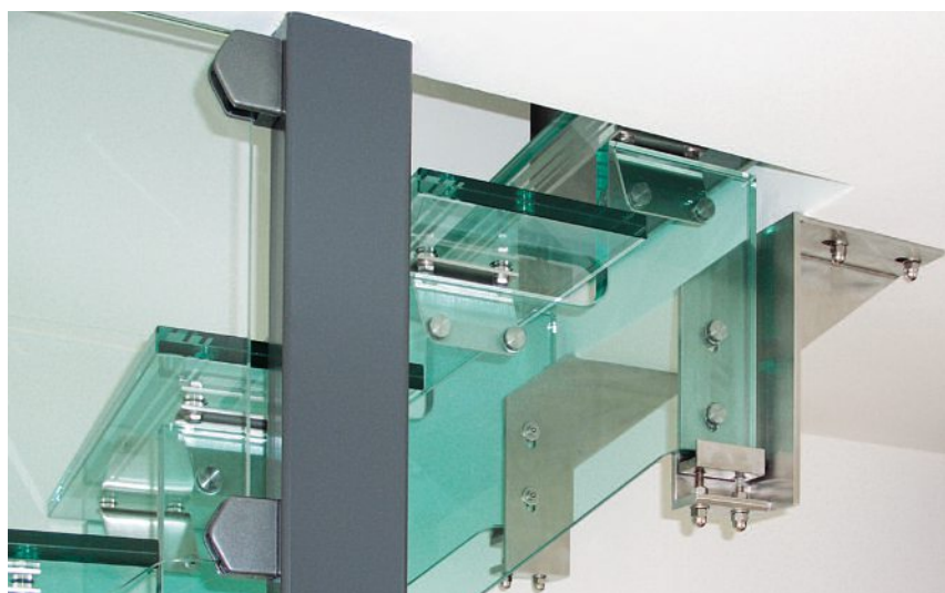
Abstützung auf verstellbaren Edelstahlkonsolen. Appui sur des consoles réglables en acier inoxydable.
