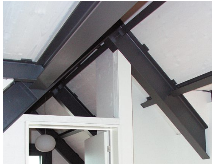
Auch die Tragstruktur des Hausdaches ist aus Stahl gebaut. La structure porteuse de la toiture est également réalisée en acier.
