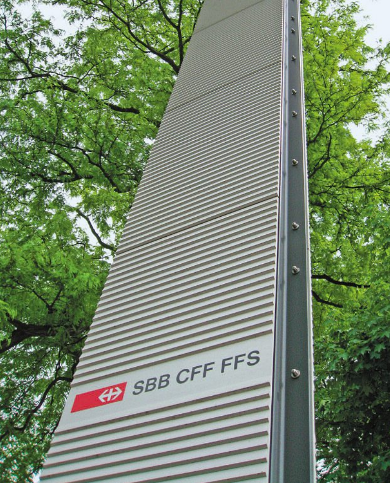
◀ Die «Lichtstele» ist mit Aluminium-Reflektoren-Platten verkleidet und wird nachts beleuchtet.
