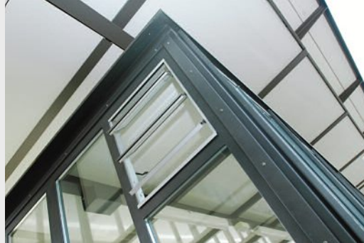
◀ «Wartehalle» mit integrierten Lamellenfenstern.
