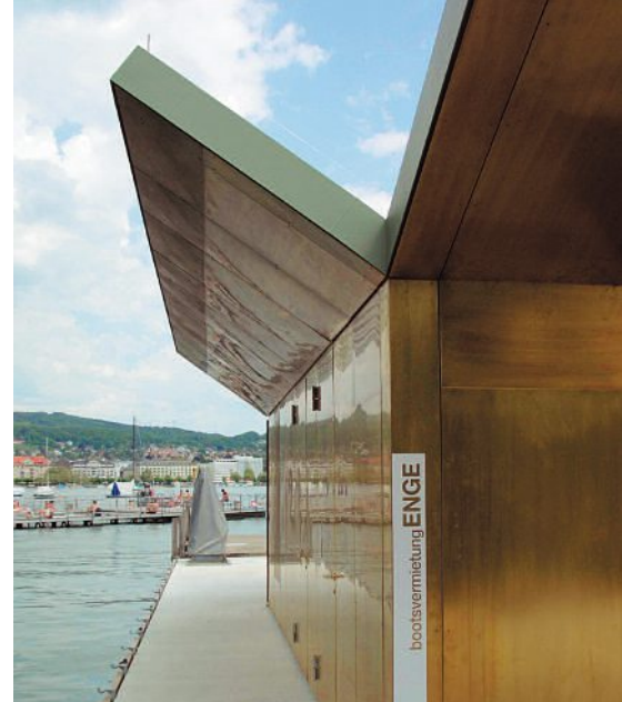
Die Dachuntersichten sind zur Gewährleistung der Belüftung perforiert ausgeführt. Les parties inférieures du toit ont été perforées de manière à garantir une ventilation adéquate.
