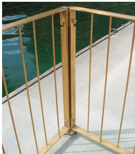
Die feingliedrigen Staketen des Messinggeländers sind versetzt angeordnet. Les fines clôtures de la rambarde en laiton sont alignées alternativement.
