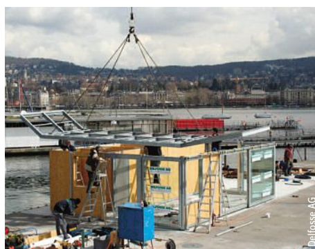
Montage des ersten Teils des Daches. Assemblage de la première partie du toit.
