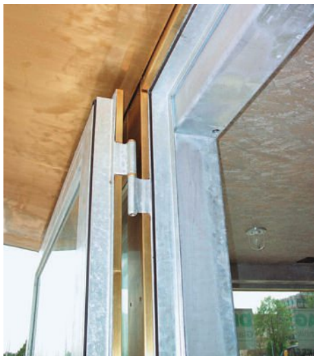
Banddetail der überdimensionalen Flügeltüre. Vue détaillée des énormes portes battantes.
