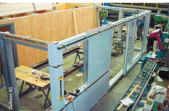
Die Vertikalfrenten sind im Werk komplett zusammgebaut worden. Les façades verticales ont été entièrement assemblées à l'usine.
