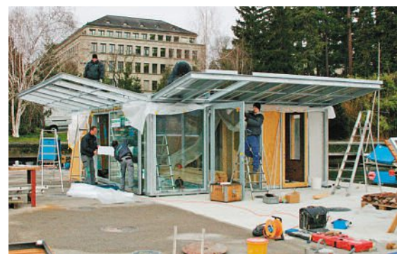
Der Pavillon konnte in nur einem Arbeitstag aufgerichtet werden. Une seule journée de travail a suffi pour construire le pavillon.
