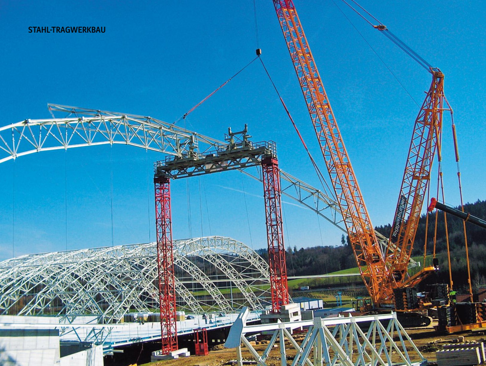
Bogenmontage auf Hilfsbrücke mit «Justierböcken». Montage des arcs sur le pont de fortune à l'aide de dispositifs d'ajustage.
