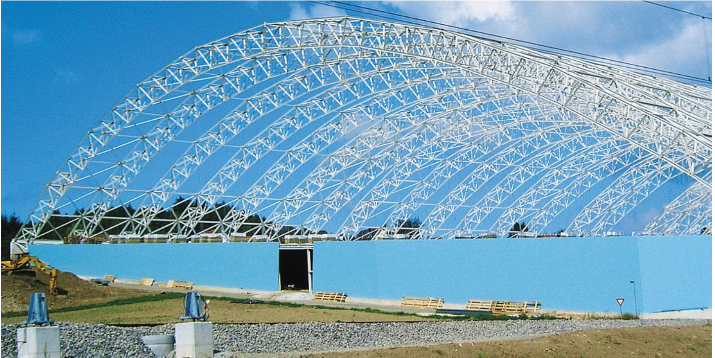
170 m breit und 32 m hoch sind die gigantischen Stahljoche der Abbauhalle.
