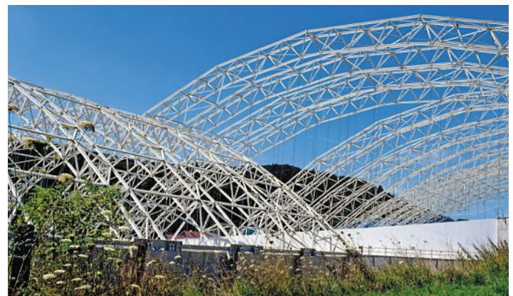
Mit einer Breite von 88 m und einer Höhe von 18 m ist die Manipulationshalle (links) doch wesentlich kleiner.
