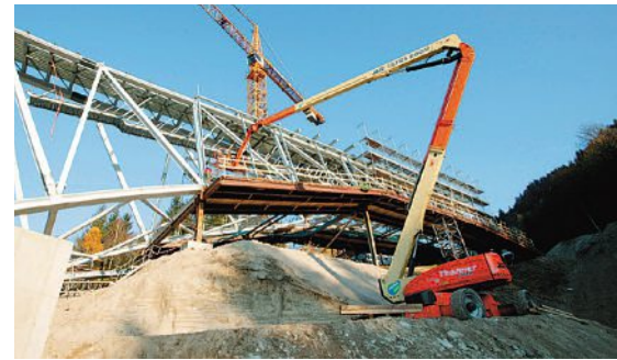
Die Arbeitsbühne mit dem riesigen Gelenkarm gewährte ein optimales Arbeiten in allen Positionen.
