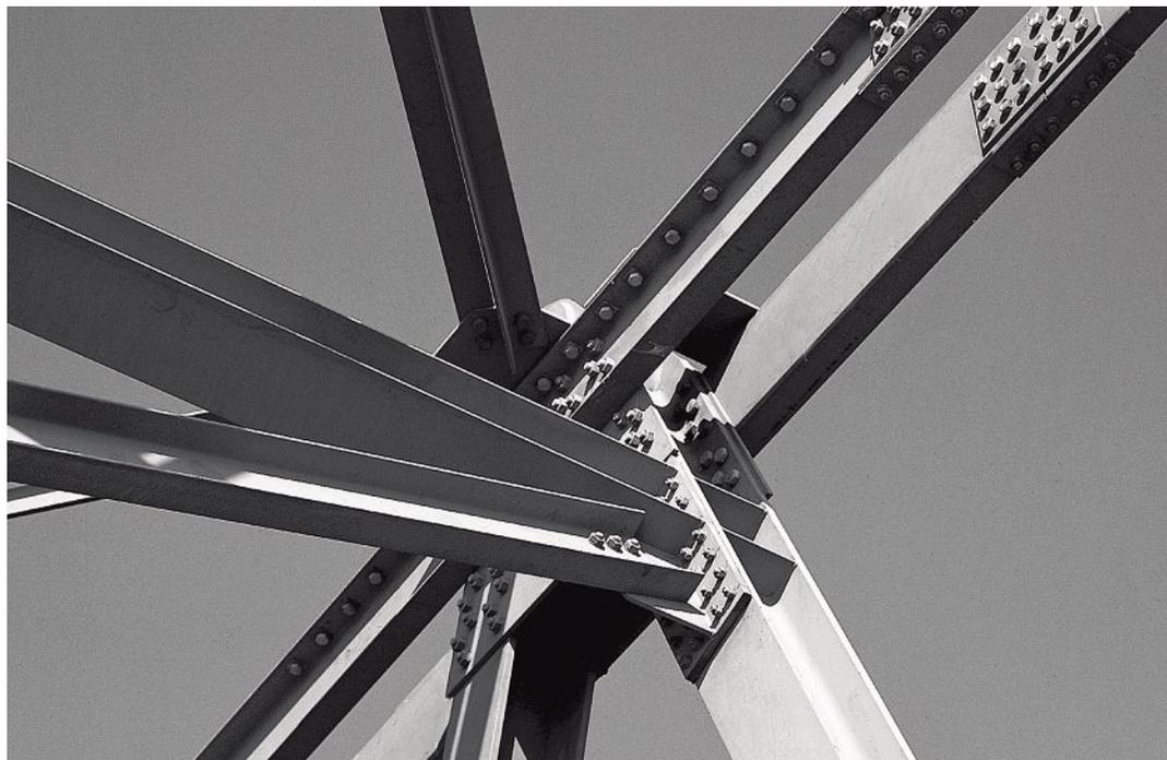
Mit HV-Schrauben der Festigkeitsklasse 10.9 werden bei gleichem Kraftanschluss weniger HV-Schrauben benötigt.
