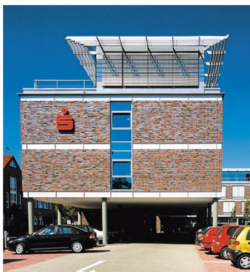
Äussere Lamellenbeschattungen schützen das Dachgeschoss vor direkter Sonneneinstrahlung. Des stores extérieurs à lamelles protègent l'étage sous le toit contre l'insolation directe.
