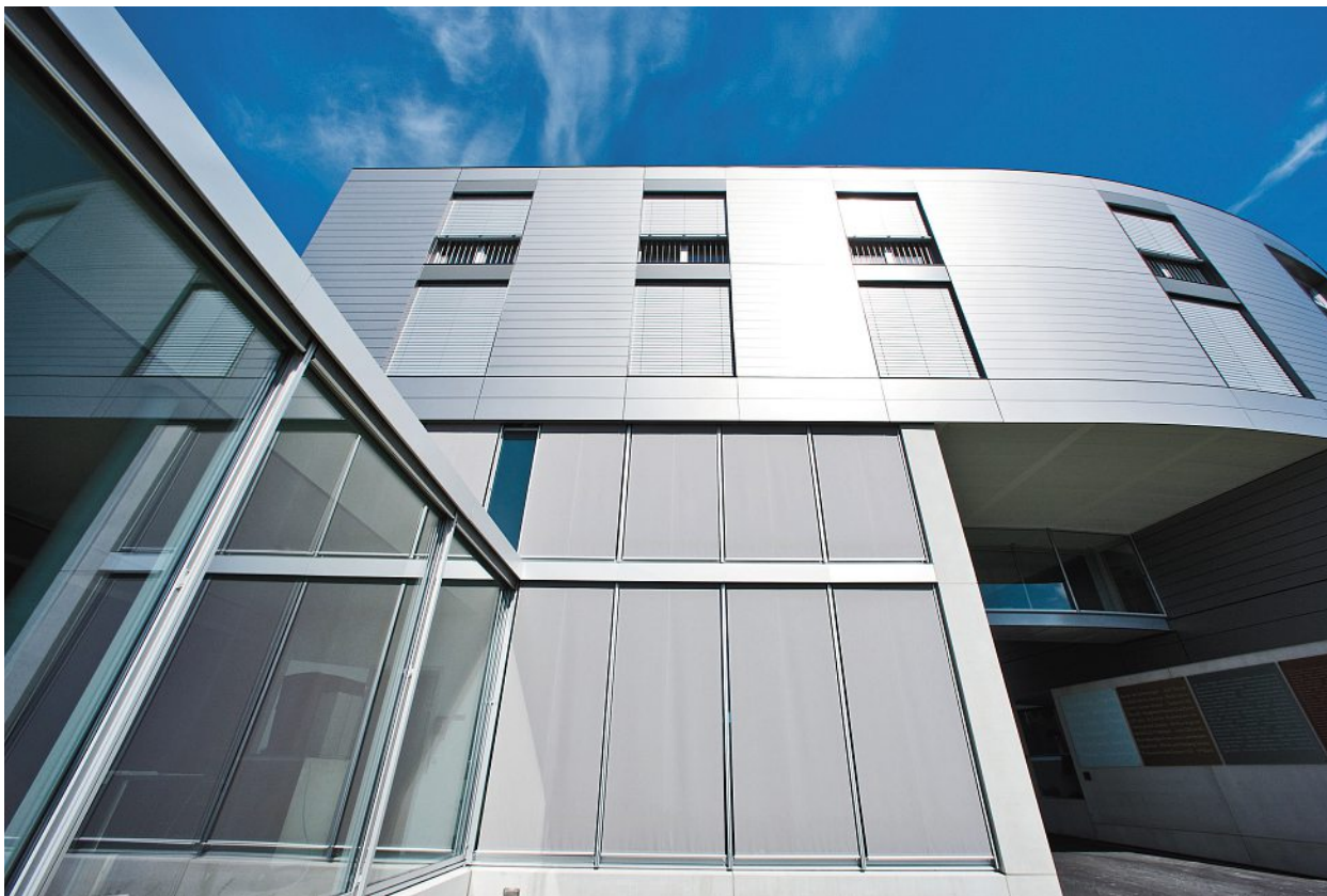
Am Neubau des Executive Campus der HSG St. Gallen setzte Griesser in den Obergeschossen die klassischen Verbundraffstoren Lamisol und im Erdgeschoss die Ganzmetallstore Metalunic ein.
