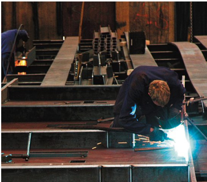
Schweissarbeiten im Werk: Die Seitenbleche werden mit den Flanschblechen verschweisst.
