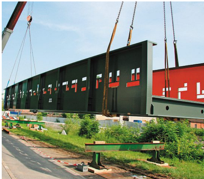
Auf den Stahlböcken entlang der Kleinen Emme werden die Brückenteile verschweisst.
