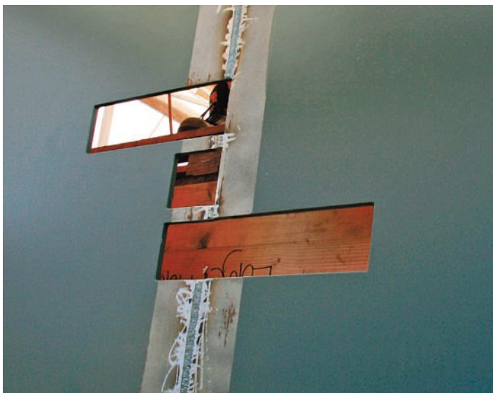
Komplett durchgeschweisst und sauber verschliffen. Soudures complètes et égalisation propre.
