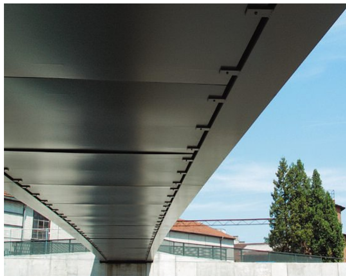
Die Untersicht ist zur Verhinderung von Wassereintritt mit Stahlblechen beplankt. La partie inférieure est bordée de tôles d'acier pour empêcher l'eau de s'infiltrer.
