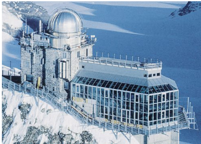
SILVERSTAR TRIII wird mit einem Wärmedurchgangskoeffizient («U-Wert») von 0,5 W/m 2 K auch höchsten Anforderungen gerecht.
