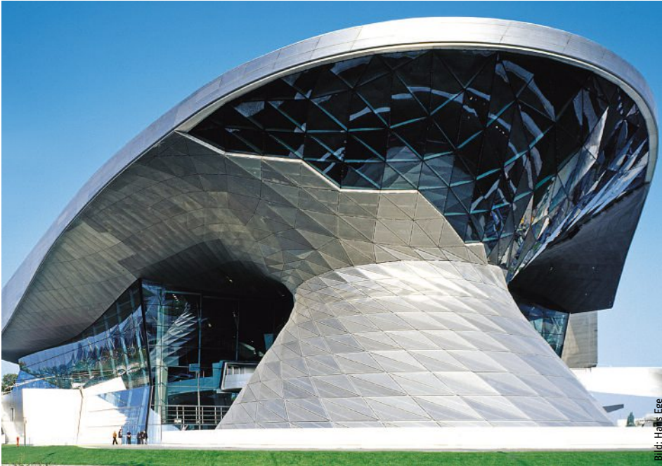
Der wie ineinander verschraubt wirkende Doppelkegel ist ein Hauptauflager des Daches. Le double cône dont chaque partie paraît vissée l'une dans l'autre constitue un support principal du toit.
