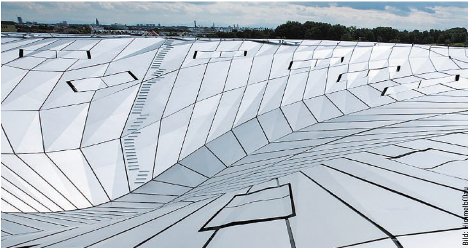
Detailansicht der Dachabdeckung. Aperçu détaillé du revêtement du toit.
