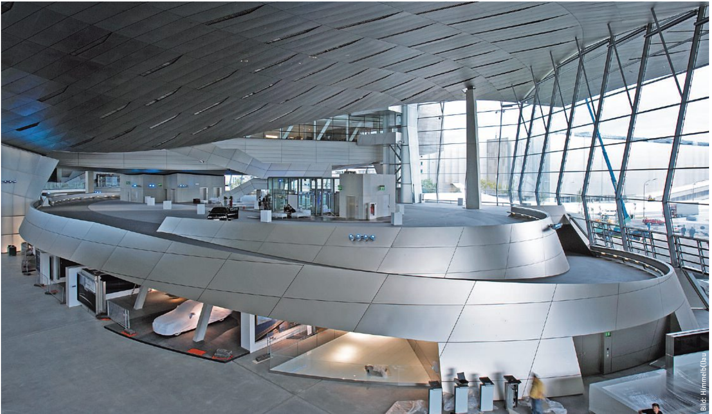
Die Verkleidungen sind aus perlgestrahlten Edelstahlblechen gebaut. Les revêtements sont construits en tôle d'acier inoxydable sablées.
