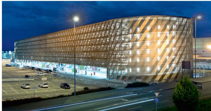
mente schmiegen sich reliefartig um den massiven Stahlverbundbau und bilden eine robuste Aussenhaut mit sensibler Erscheinung. In verschiedenen Gold- und Brauntönen schimmernd, strukturiert die dreidimensionale Metallfassade die grosszügigen Fassadenflächen und dient dabei als Sichtschutz, während sie stets einen grosszügigen, dennoch diffusen Lichteinfall ermöglicht.
