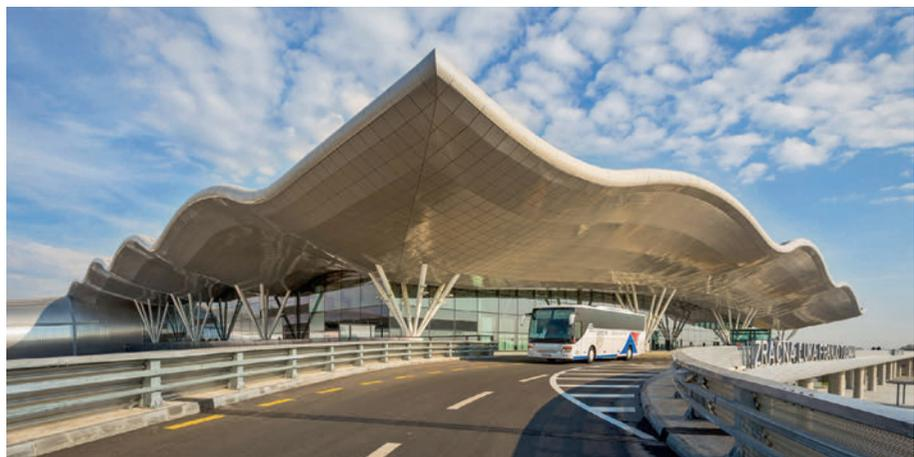
und 6100 Knoten. Gleich einer sich überschlagenden Welle schliesst es zu den Gates hin nach innen gebogen ab. Zusammen mit dem lichten Tragwerk schaffen grossformatige Glasflächen an den seitlichen Fassaden eine hohe räumliche Transparenz. Das Dachtragwerk über dem Hauptvolumen ist wie folgt aufgebaut: Die Basis
