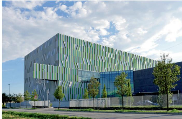
Aluminiumpaneelen verkleidet, auf die lineare Aluminiumprofile angebracht sind. Sie sind in drei unterschiedlichen Grünnuancen gefärbt, die Gräser und Halme verkörpern
