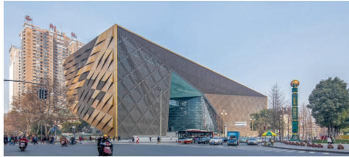
Flechtwerk-Ästhetik verkleidet ist. Die gefaltete, von der Betonstruktur des Gebäudes weitgehend unabhängige Gebäudehülle wird von einem riesigen Fachwerk aus Stahldiagonalen getragen. Der Neubau reicht bis zu 24 Meter tief in den Untergrund. Die Fassadenstruktur – im Osten nur leicht verhüllt, im Westen ganz geschlossen – entspricht nicht nur
