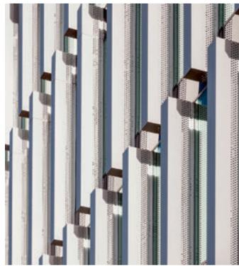
das Glasdach des Atriums sind Solarzellen integriert. Die Fassaden sind dreifach verglast und werden von vertikalen Aluminiumlamellen verschattet, die je nach Ausrichtung eine unterschiedliche Tiefe besitzen. Die ungewöhnliche Breite der Elemente erklärt sich daraus, dass sie zugleich der natürlichen Belüftung dienen. Dazu sind sie seitlich mit einer Perforation und an der Rückseite mit Lüftungsflügeln versehen, die sich manuell öffnen lassen. Quelle: Detail.de ■
